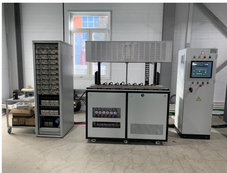
Рис. 3. Внешний вид многопозиционной установки обезгаживания ЭВП
