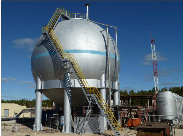
Рис. 11. Резервуар РС-1400/0,4. Монтаж закончен.
