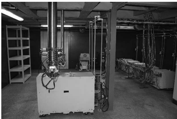
Рис. 4. Форвакуумные откачные посты, гелиевые и воздушные компрессоры
