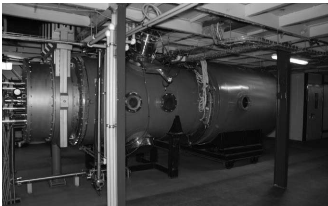
Рис. 3. Рабочая камера испытательного стенда 71-2-85 после модернизации.
