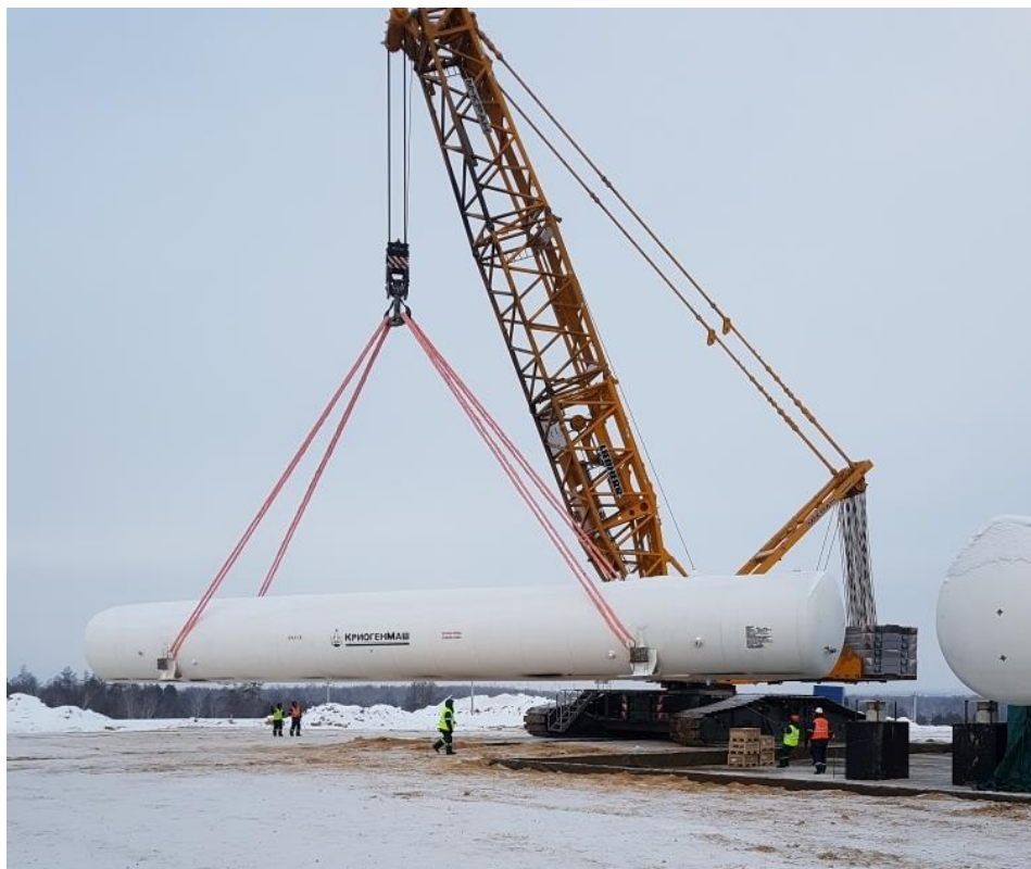
Рис. 1. Монтаж криогенного резервуара РЦГ-250 краном грузоподъёмностью 750 тн на космодроме "Восточный".
