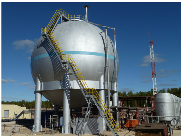
Рис. 11. Резервуар РС-1400/0,4. Монтаж закончен.
