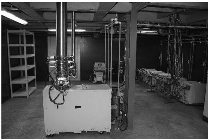
Рис. 4. Форвакуумные откачные посты, гелиевые и воздушные компрессоры
