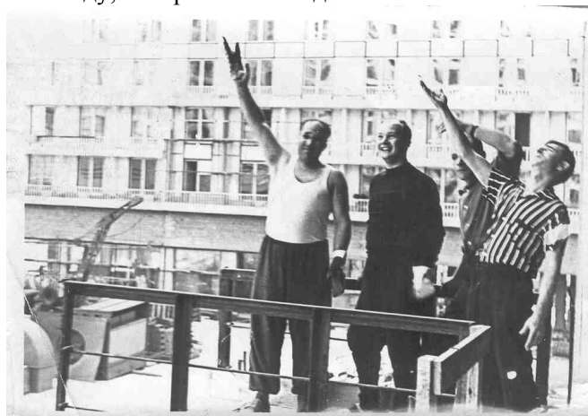
Рис. 2. Сотрудники НИИВТ на строительстве гостиницы «Россия» в Зарядье. 1966 год.
